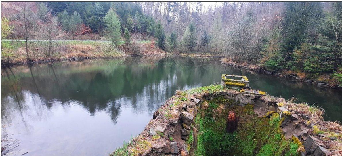
Pohled na pravou přelivnou hranu u sdruženého objektu a celou vodní nádrž. Břehy jsou opevněné lomovým kamenem a částečně zarůstají makrofytní vegetací a nálety dřevin. Vlevo břehy navazují na pravidelně udržovaný travinobylinný porost a lesní cestu „Schindlerova“ a okolní lesní porosty.
